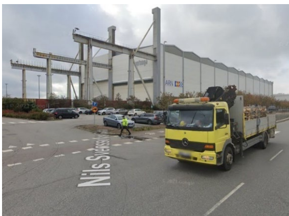
Bild. Före detta Arendalsvarvet sett från nordöst, den 30 m höga skrovhallen med traverser
